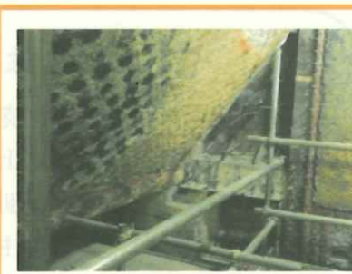
【耐火物の点検】
