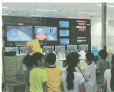
中央制御室を見学している様子
