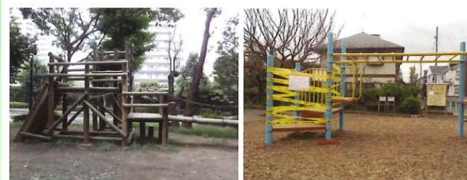
▲経年劣化した遊具
