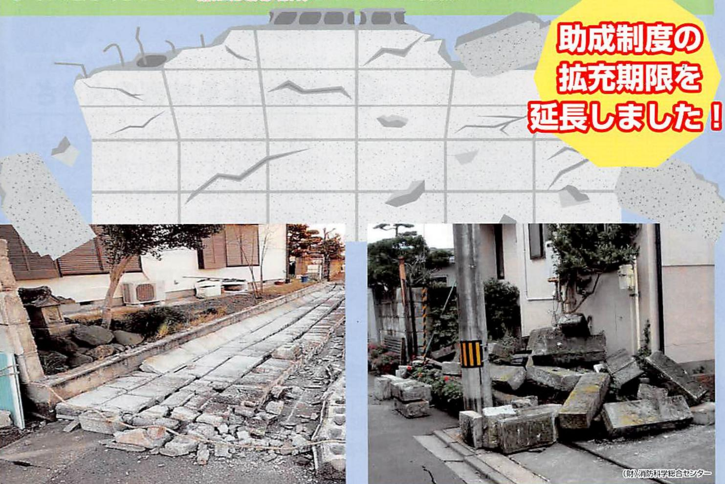
地震により倒壊したブロック塀の様子
