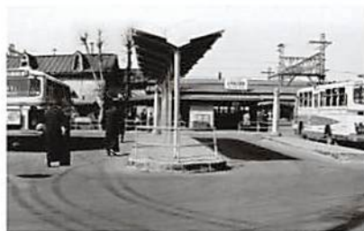
▲旧 石神井公園駅駅舎
