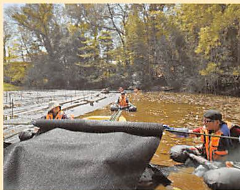
ボートを駆使して隙間がないように丁寧にシートを設置するボランティア
