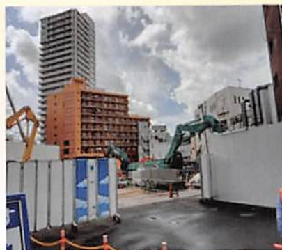
▲解体工事が進んでいる現場
