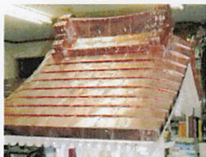
銅板屋根の例
