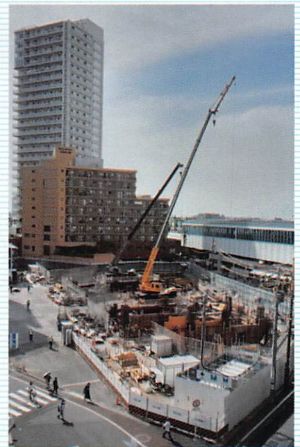
▲2年後に完成を目指し建設中の超高層ビル(6月1日撮影)
