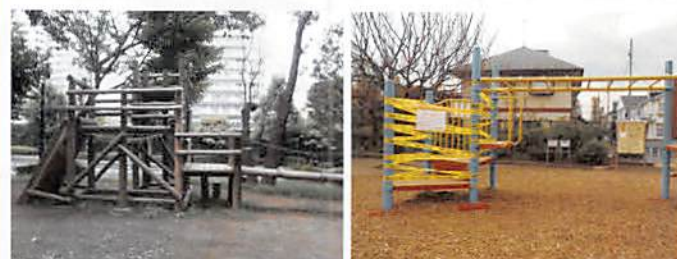
▲経年劣化した遊具
