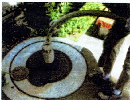
②吸管の先は、空気を吸わないように、しっかり水の中に沈めます。
