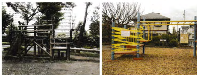
▲経年劣化した遊具
