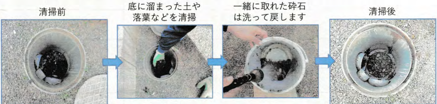
浸透ますの清掃例
