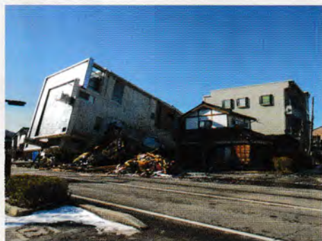
輪島市の被害状況
