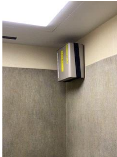
4. 設置後の写真
