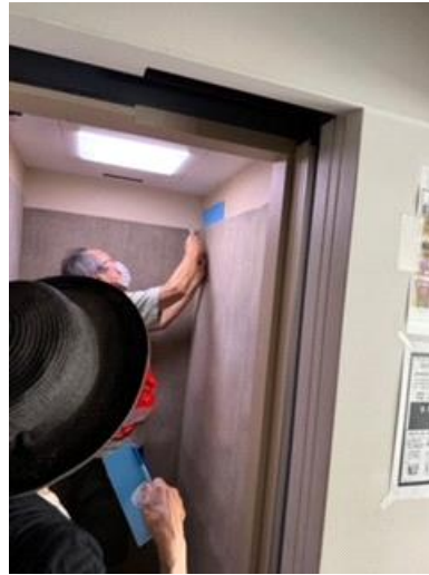
2. 養生布の一部カット
