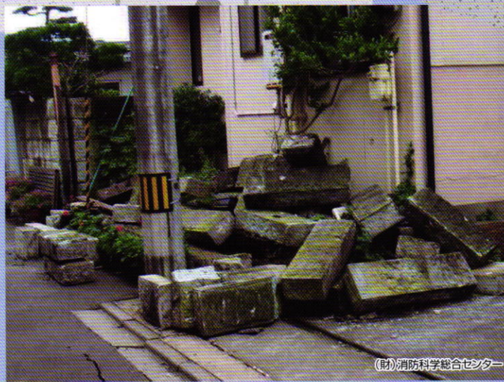
地震により倒壊したブロック塀の様子
