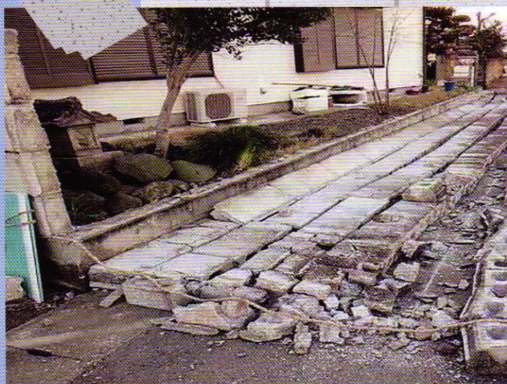
地震により倒壊したブロック塀の様子
